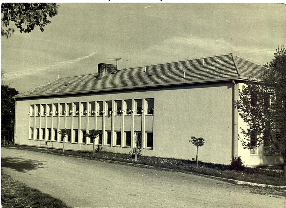
nová přístavba školy z r. 1962
