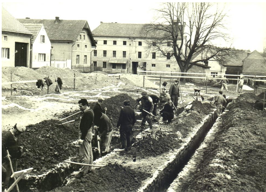
r. 1975 – výkopové práce pro nové dílny a tělocvičnu
